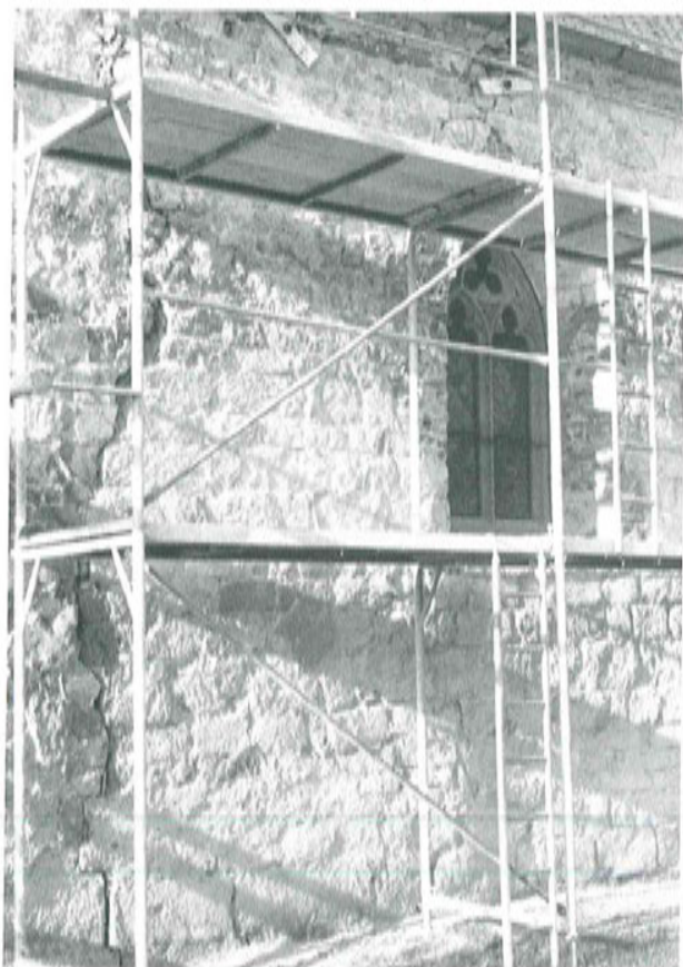
Abb. 4: Bergham, Südwand des Langhauses nach der Entfernung des Putzes 1980.
