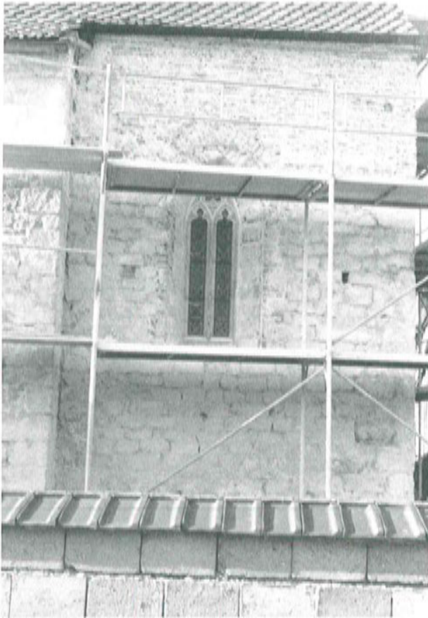
Abb. 5: Bergham, Südwand des Altarraumes nach der Entfernung des Putzes 1980.
