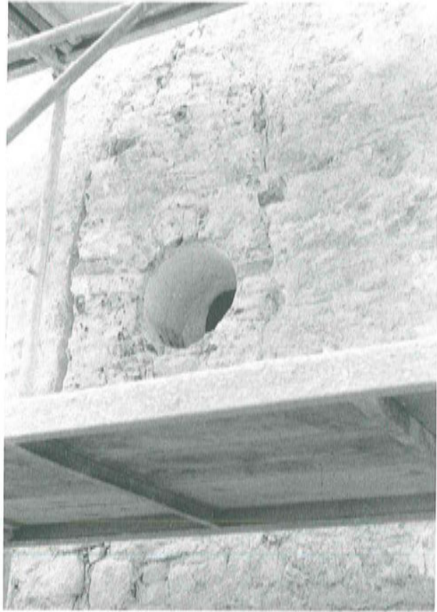
Abb. 2: Bergham. Vermauertes spitzbogiges Fenster an der Ostwand des Altarraumes mit heutiger runder Ausformung (1980).
