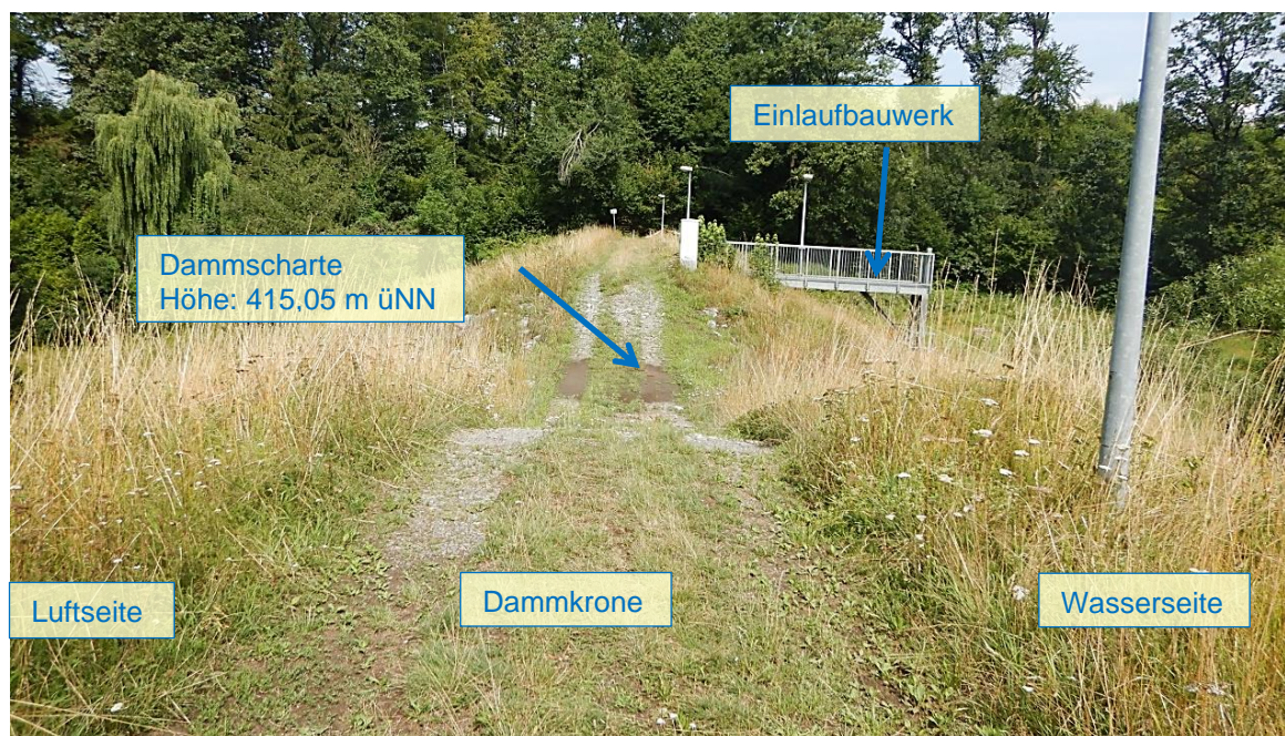
Abbildung 4.4: Blick auf die Dammscharte in Richtung Nordwest
