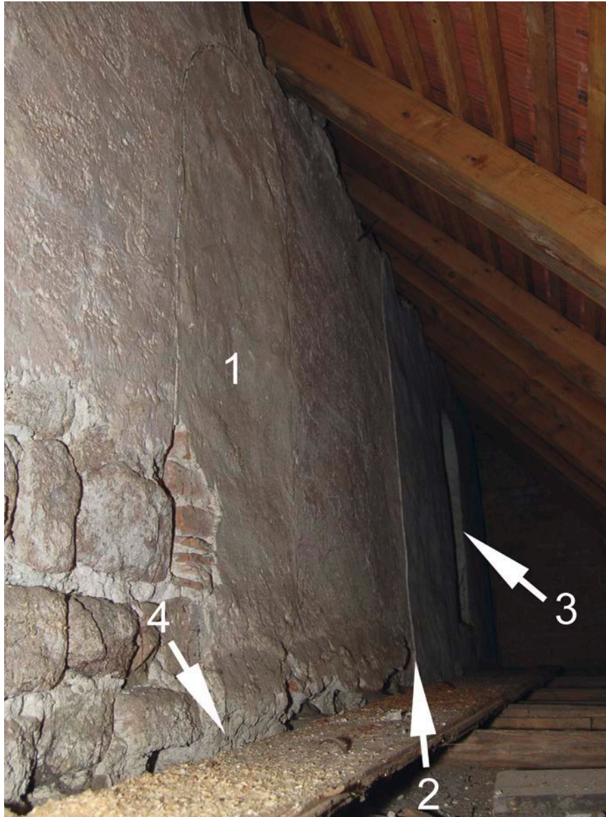
Abb. 14: Künzing-St. Laurentius. Obergadenwand im östlichen Bereich des Seitenschiffrestes mit zweitem und drittem Obergadenfenster von Westen sowie Putznaht zwischen den beiden Fenstern. 1 mit Ziegeln (links unten erkennbar) zugesetztes und überputztes Fenster; 2 Naht zwischen mittelalterlichem (links) und neuzeitlichem (wohl 1940) Verputz; 3 außen offenes Obergadenfenster; 4 Ansatz des ehemaligen Seitenschiffdaches. (Foto: Schnieringer 16.10.2007)
