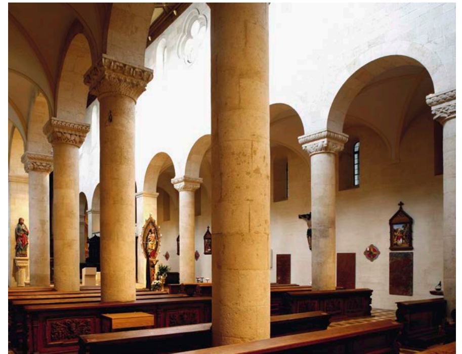
Abb. 25: Regensburg-St. Jakob. Blick in die Rundpfeilerbasilika in Richtung Südosten. Der vorderste Pfeiler zeigt sehr qualitätvolle, gleichmäßige, aus Segmenten zusammengesetzte Säulentrommeln.
