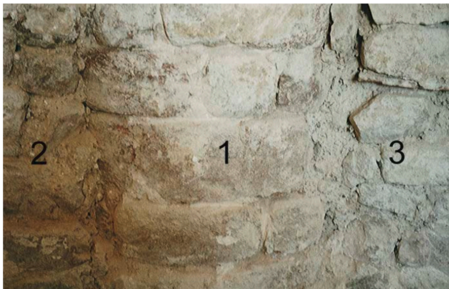
Abb. 4: Künzing-St. Laurentius. Bereits 2001 im Zuge der Wandfreilegungen zur Einrichtung eines Beichtraums innerhalb des ehemaligen südlichen Seitenschiffs sichtbarer Rundpfeiler (1). Es handelt sich um den ersten Pfeiler von Westen, dessen Position bereits im Kunstdenkmälerband dargestellt ist. Westlich (2) und östlich (3) des Pfeilers mit Abbruchmaterial vermauerte Arkaden. (Foto: Pirkl)
