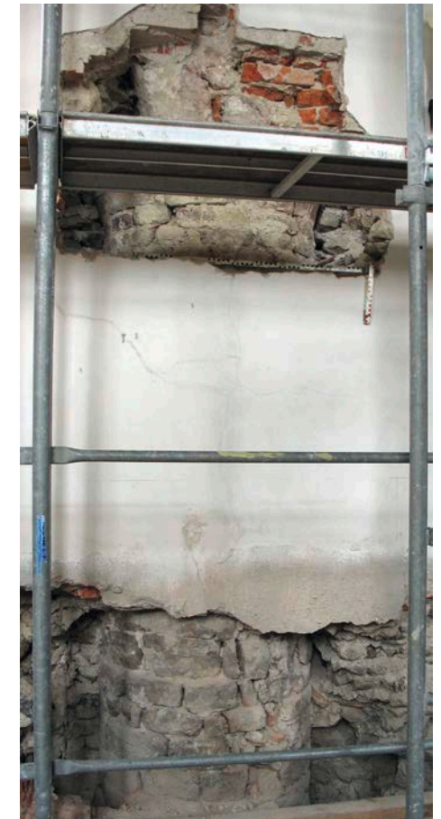
Abb. 7: Künzing-St. Laurentius. Der zur Untersuchung im Kämpfer- und Basisbereich in der Südwand freigelegte dritte Rundpfeiler von Westen. Verputzte Wandflächen blieben unberührt. (Foto: Schmotz 30.8.2007)
