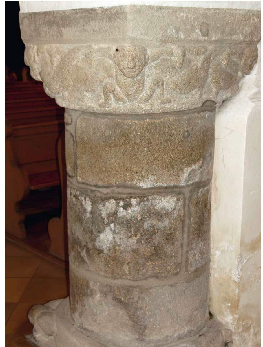
Abb. 27: Nabburg-Perschen, St. Peter und Paul. Gedrungener Rundpfeiler aus Granit im Stützenwechsel der Langhausarkaden, bestehend aus drei hohen, aus Segmenten zusammengesetzten Säulentrommeln sowie einem Kapitell mit Figuralschmuck und einer Basis mit Eckzier.
