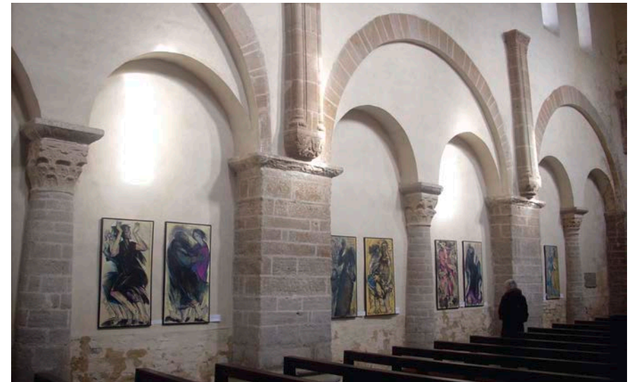
Abb. 35: Drübeck, Landkreis Harz (Sachsen-Anhalt). Ehemalige Klosterkirche St. Vitus. Nordwand des ehemaligen Hauptschiffs mit als Nischen verschlossenen Arkaden (rekonstruiert) und etwa zur Hälfte sichtbaren quadratischen und runden Pfeilern des einfachen Stützenwechsels mit Überfangbögen. (Foto: Wikimedia Commons, Kloster Drübeck: Rabanus Flavius 8.3.2010)
