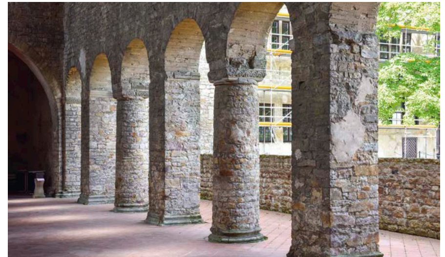
Abb. 36: Leitzkau, Lkr. Jerichower Land (Sachsen-Anhalt). Ehemalige Klosterkirche Sancta Maria in monte. Rekonstruktion der nach 1564 zur Schlosskirche umgebauten Basilika mit einfachem Stützenwechsel nach dem Zweiten Weltkrieg, veranlasst durch Kriegsschäden. Das Bild zeigt die frei stehende Langhausarkade zum ehemaligen nördlichen Seitenschiff.
