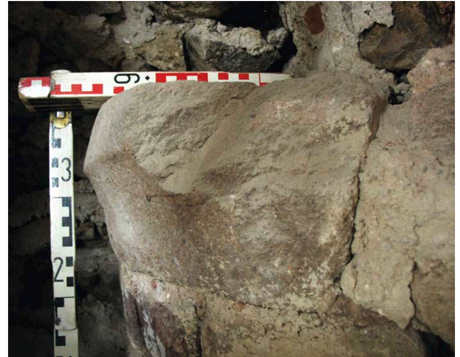
Abb. 11: Künzing-St. Laurentius. Detail des Kämpferprofils an der Nordostseite des Pfeilers. (Foto: Schmotz 29.8.2007)
