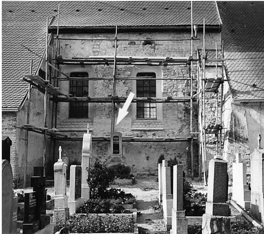
Abb. 31: Künzing-St. Laurentius. Verputzfreie Südwand. Zwischen den beiden Fenstern auf Höhe der Sohlbänke (Pfeil) Abschrägung einer Vormauerung zur Verdeckung der Langhausarkaden, die sich auch westlich und östlich der Fenster zeigt.
