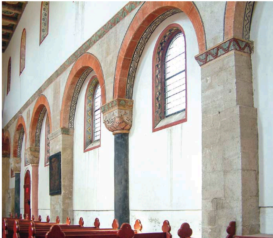
Abb. 34: Kloster Gröningen, Landkreis Börde (Sachsen-Anhalt), ehemalige Klosterkirche St. Cyriakus. Das ehemalige Hauptschiff – beide Seitenschiffe wurden zu unterschiedlichen Zeiten abgebrochen – zeigt etwa zur Hälfte der Wandstärke geschlossene Arkaden mit Nischen und Säulen! (Foto: Faure, Goslar, 24.4.2003).
