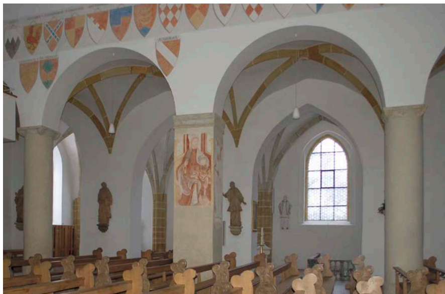
Abb. 28: Kastl, ehemalige Klosterkirche St. Peter. Westlicher Beginn der nördlichen Langhausarkade mit einfachem Stützenwechsel. Die leicht getünchten Rundpfeiler bestehen aus Segmenten zusammengesetzter Säulentrommeln und weisen glatte Kämpfer mit knollenartigen Spornen an den Ecken auf. (Foto: Peschke, Bamberg, 2.2.2019, leicht verändert)
