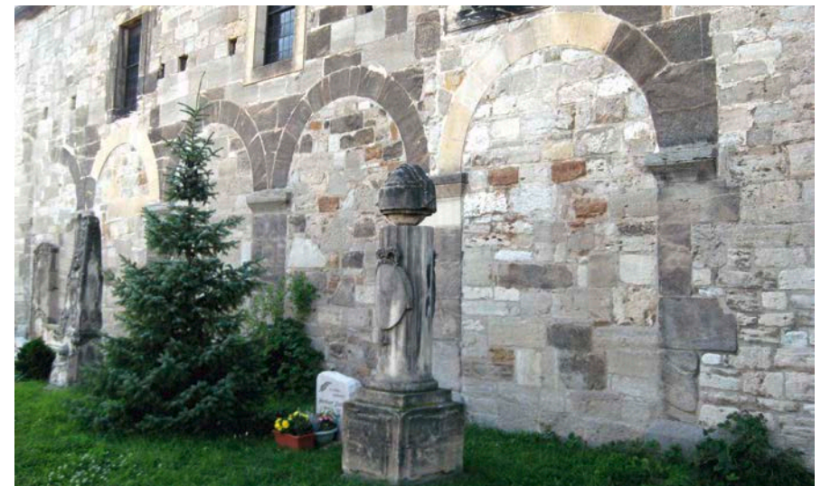
Abb. 33: Arnstadt-Oberndorf, Ilm-Kreis (Thüringen), St. Nikolai. Mit gutem Abbruchmaterial zugesetzte Arkaden in der Südwand ohne Veränderungen an Pfeilern und Kämpfern.
