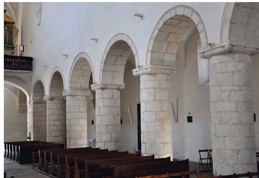
Abb. 29: Milevsko-Mariä Heimsuchung. Blick in die nördliche Langhausarkade nach Nordwesten mit aus Trommelsegmenten zusammengesetzten und getünchten, mit rotbrauner Fugenbetonung versehenen Rundpfeilern. (Foto: Schmotz 20.8.2011)
