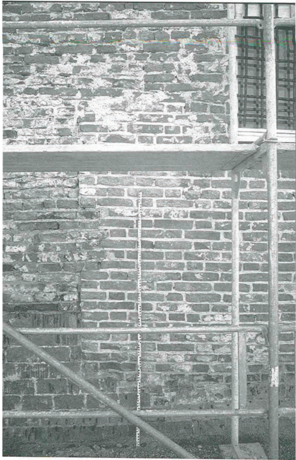
Abb. 10: Lailling – St. Nikolaus. Sakristei-Nordseite mit Baufuge (30. 3. 1994).
