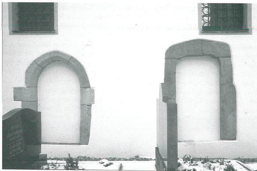
Abb. 6: Lailling – St. Nikolaus. Vermauerte mittelalterliche Eingänge an der Südseite (12. 1. 1995).
