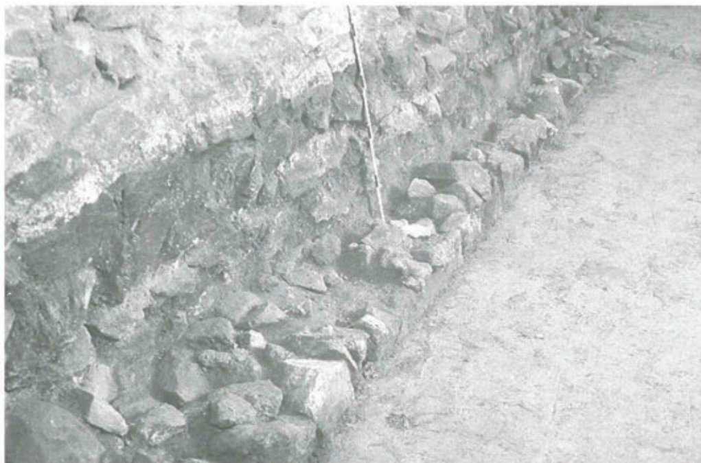
Abb. 10: Steinkirchen – St. Maria Magdalena. Fundamentverlauf des ältesten Baues an der Südseite.
