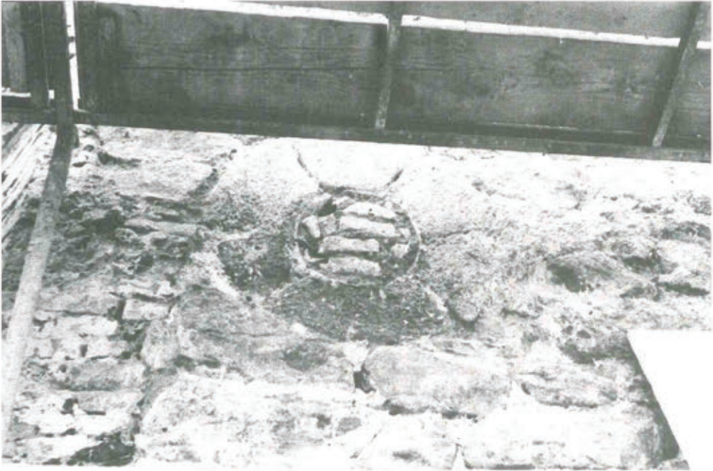
Abb. 14: Steinkirchen – St. Maria Magdalena. Rundfenster an der Nordwand.
