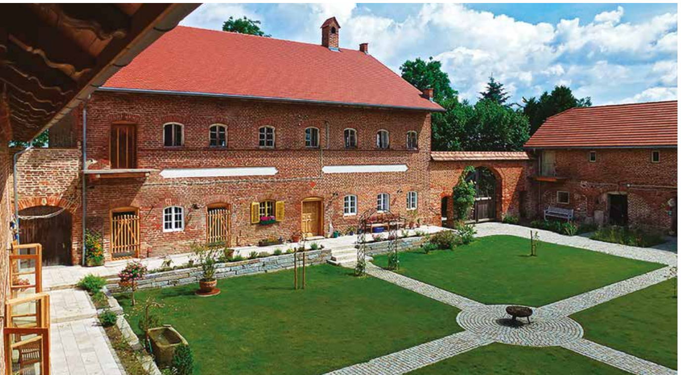
Rottaler Vierseithof in Denhart in der Gemeinde Tann
