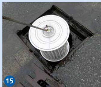
15 Filterpatrone in den Straßenablauf einsetzen. Anschließend den Grobfilter aufsetzen und den Straßenablauf wieder mit dem Gussrost verschließen.
