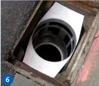
Oberteil des Einsatzes in die Gussabdeckung einsetzen und mit dem Unterteil höhengerecht verschrauben.
