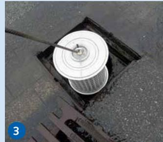
Filterpatrone aus dem Einsatz entnehmen...
