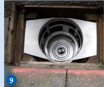
Gefüllte INNOLET®-G-Filterpatrone in den Einsatz einhängen (8-9).
