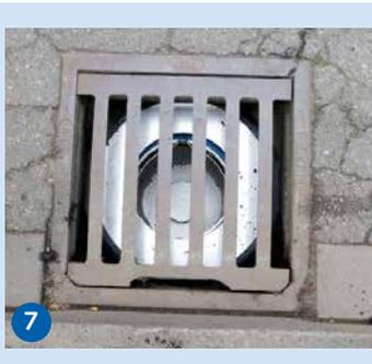
7 Gussabdeckung einlegen, fertig eingesetztes INNOLET®-System.
