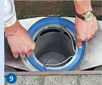
Substrat gemäß Anleitung (siehe „Austausch Substrat“) in die INNOLET®-Filterpatrone füllen. INNOLET®-Filterpatrone in den Einsatz einbringen, auf Zentrierung achten und dann den Grobfilter einsetzen und fest reindrücken. Der Grobfilter muss sich mit der Filterpatrone zentrieren und die Dichtung am Grobfilter muss sich hochklappen (siehe Bild 9).
