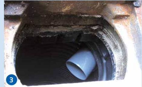
Lieferumfang: INNOLET®-G-Einsatz mit Verteilerkegel, INNOLET®-G-Filterpatrone, Anschlusszubehör wie Stutzen und Flexschlauch mit Spannbändern, INNOLET®-Filtersubstrat
