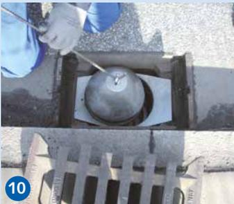
Doppelkegel in den Einsatz einschieben, so dass der Doppelkegel auf der Filterpatrone bündig aufsitzt (10-11).
