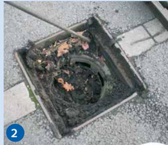
Grobfilter entfernen und reinigen.
