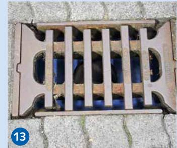
Damit das gesamte Oberflächenwasser durch das INNOLET®-System geleitet wird, muss bei rechteckigen Straßenabläufen eine Adapterplatte angepasst werden. (Bei quadratischen Straßenabläufen normalerweise nicht notwendig.)
