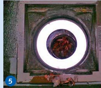
5 Filterpatrone befüllen und einsetzen, ebenfalls den Grobfilter einsetzen (gemäß Einbau INNOLET® Rechteck/Quadrat Position 6–9). Runde Adapterplatte auflegen (Bild 5 und 6).
