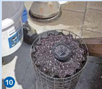
Schwarze Kappe abnehmen, Filterpatrone mit Deckel verschließen und Ringmutter festdrehen.
