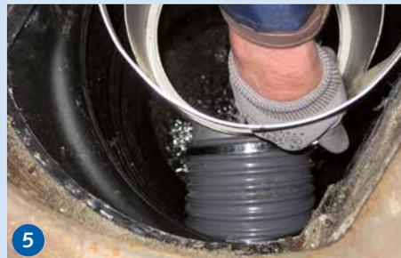
INNOLET®-G-Einsatz losschrauben und das Unterteil in den Straßenablauf einsetzen. Flexschlauch auf dem Stutzen montieren (5) und mit Spannband sichern.
