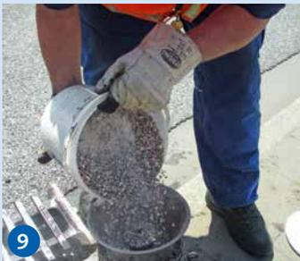
Filterpatrone mit Substrat füllen.
