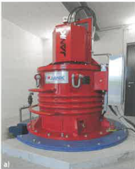
Bild 8: Prototypenanlage: a) Krafthaus mit PM-Generator im Vordergrund, b) 3-Flügler-Laufrad, c) Einlaufspirale, d) 4-Flügler-Laufrad
