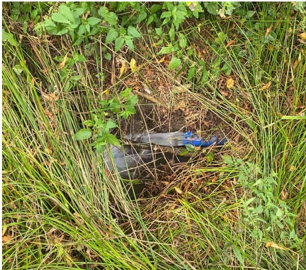
Abb. 4 Mündung PE-Leitung
