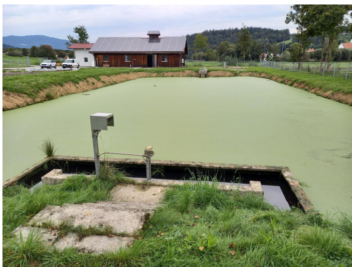
Abbildung 7: Schönungsteich und Ablaufbauwerk (Stand: September 2025)
