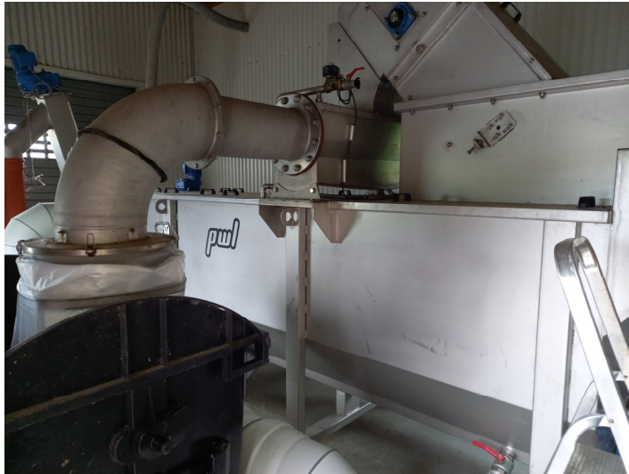
Abbildung 2: Umlaufraufrechen (Stand: September 2025)
