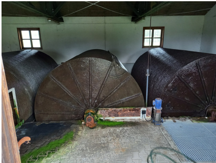
Abbildung 5: Scheibentauchkörperanlage (Stand: September 2025)
