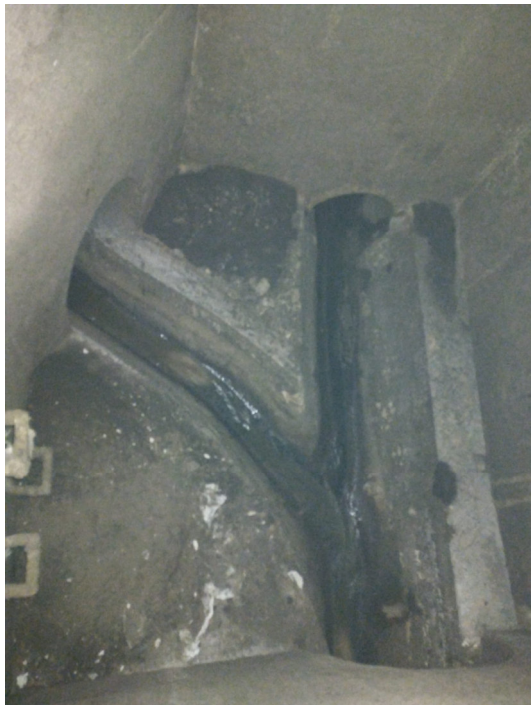
Abbildung 13: Innenansicht BÜ 1 (Stand: September 2025)
