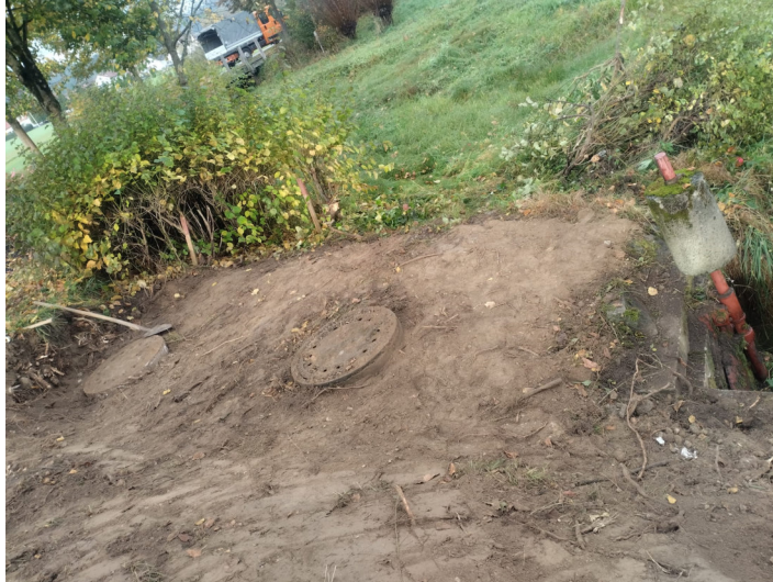
Abbildung 12: Außenansicht BÜ 1 (Stand: September 2025)
