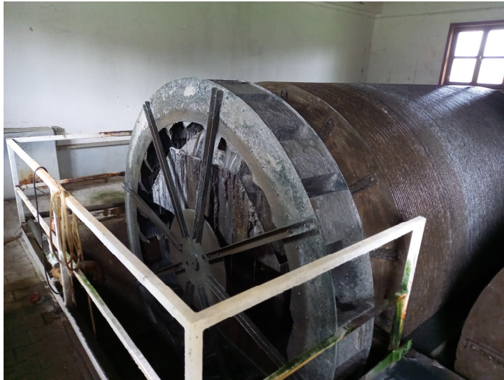
Abbildung 4: Schöpfwerk (Stand: September 2025)
