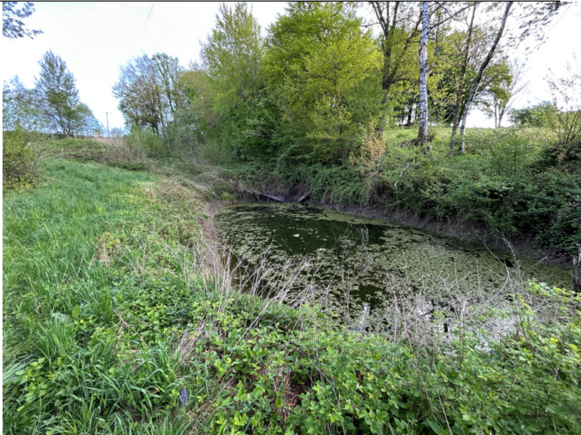
Abb. 1: bestehendes Regenrückhaltebecken mit Grundsee
