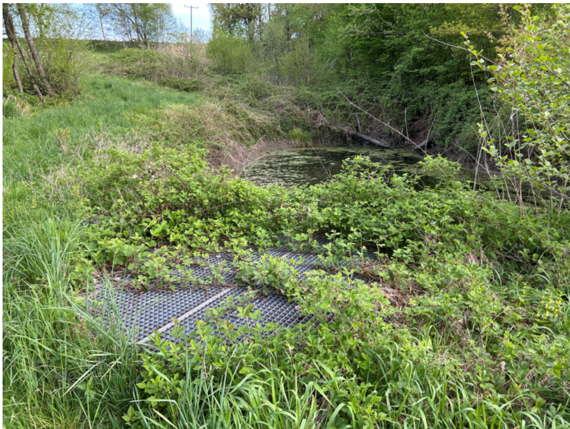
Abb. 2: bestehender Drosselschacht mit Gitterrostabdeckung
