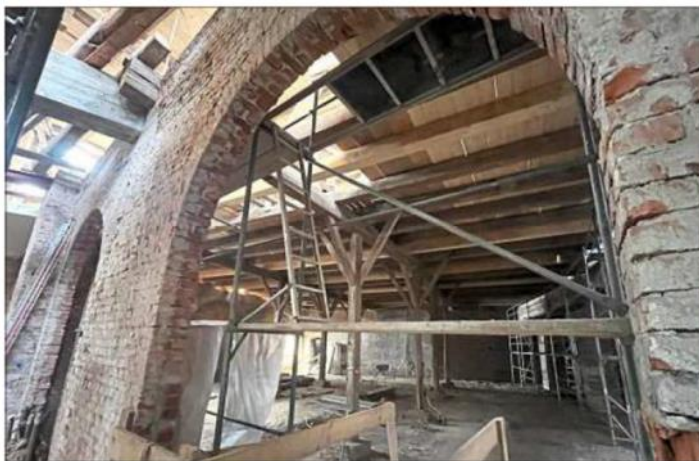
Blick vom Foyer aus in den künftigen Konzertsaal des Kulturbodens.
