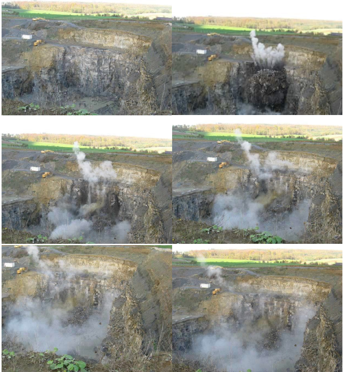
Abbildung 4. Sprengung von Kalkgestein in einem Steinbruch; schwach windig.
