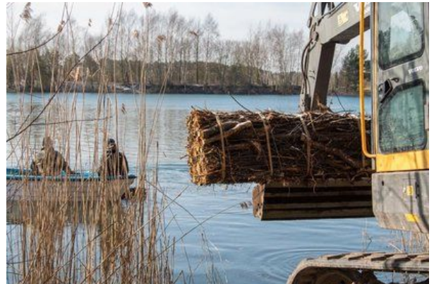
Abbildung 6: Totholzbündel während der Einbauphase
